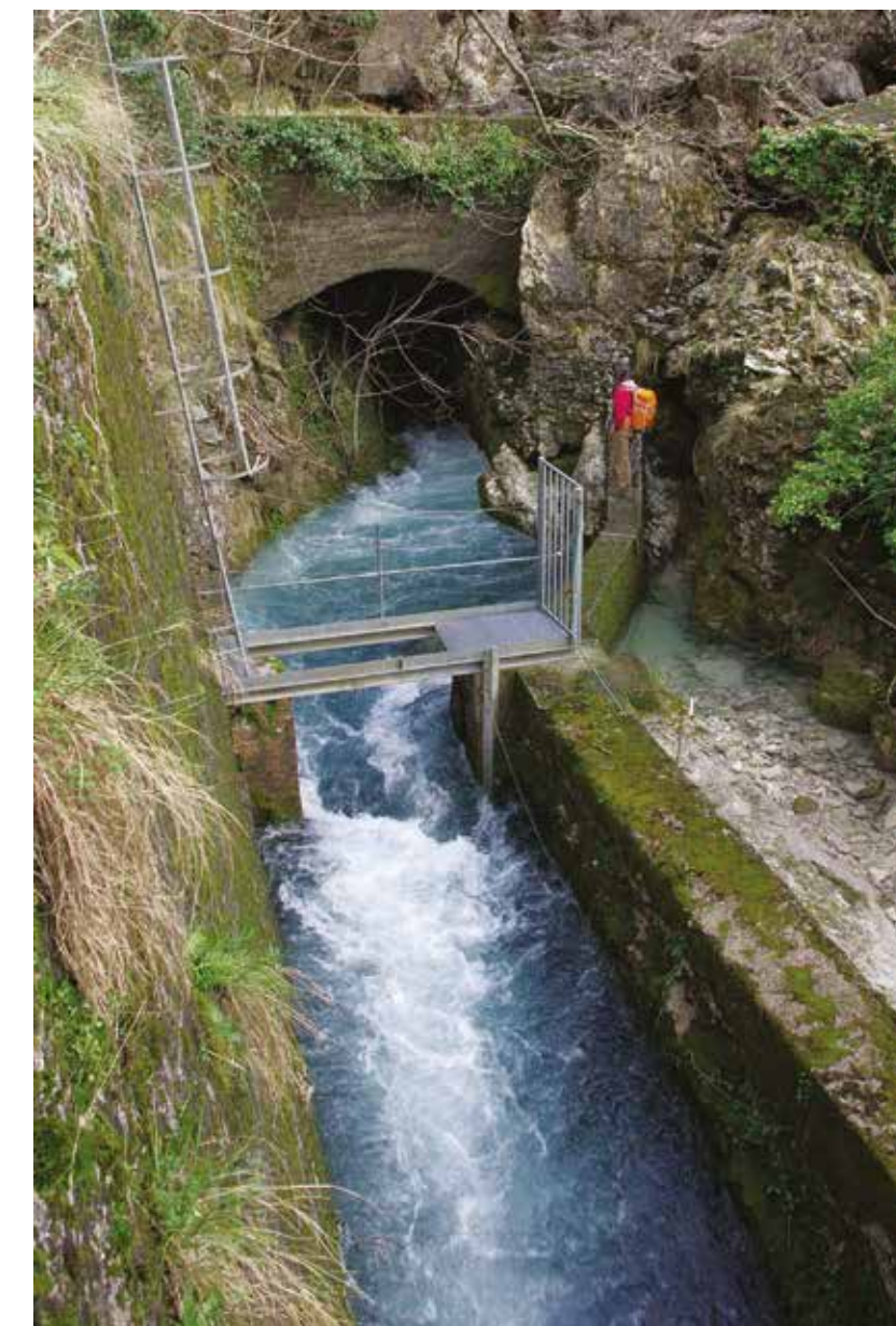
LA SORGENTE DEL FRIGIDO A FORNO, GRAZIE ALLA COPIOSA E COSTANTE PORTATA E' STATA UTILIZZATA PER FORNIRE FORZA MOTRICE AI MACCHINARI DELL'EX COTONIFICIO, COSTRUITO NEL XIX SECOLO. OGGI E' PARZIALMENTE CAPTATA AD USO DELL'ABITATO DI FORNO - Foto Del Testa S.
