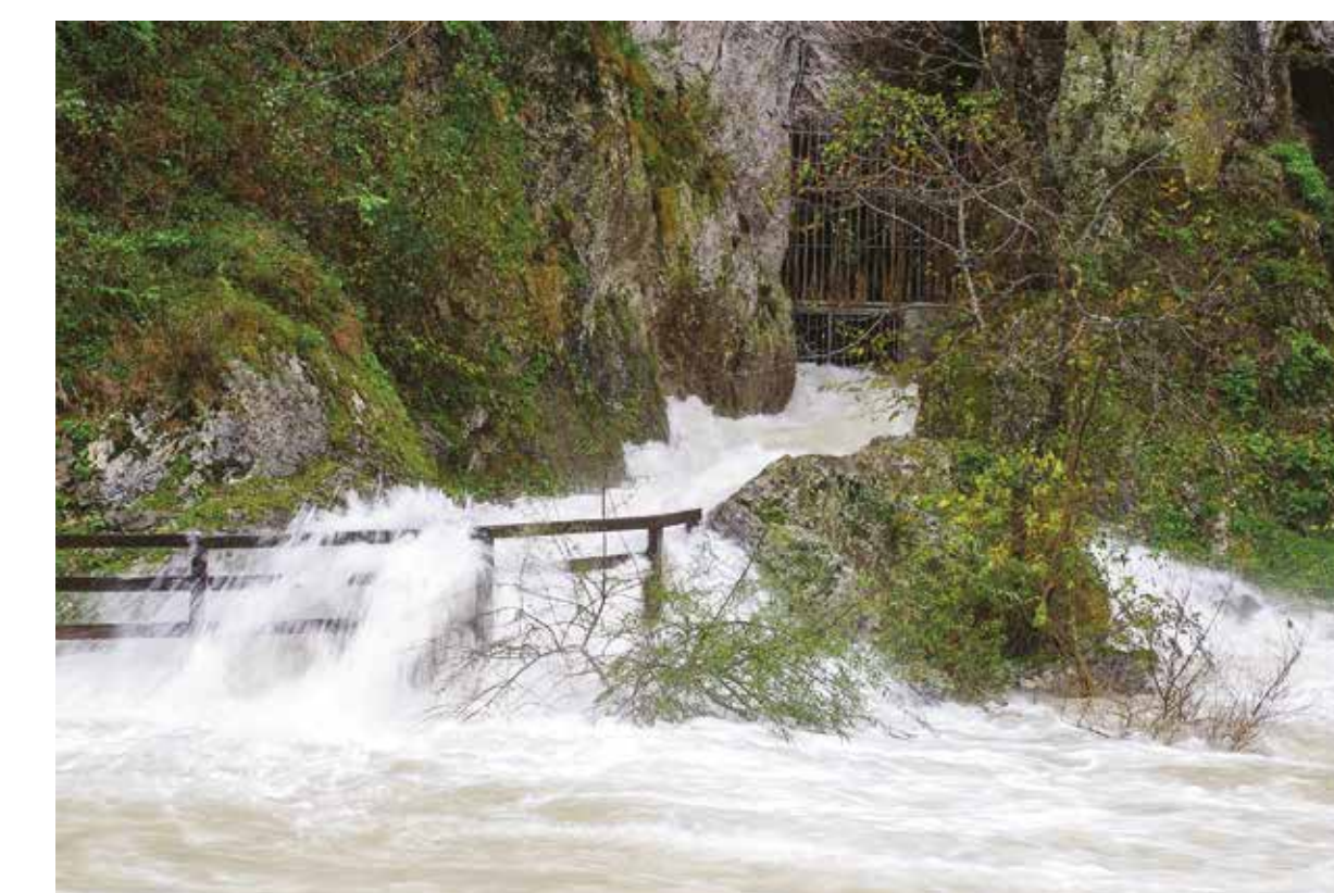
IL CANCELLO DI INGRESSO DELLA GROTTA TURISTICA DI EQUI TERME. IN CONDIZIONI DI PIENE ECCEZIONALI L'ACQUA PUO' ARRIVARE FINO A DUE METRI DI ALTEZZA - Foto Del Testa S.
